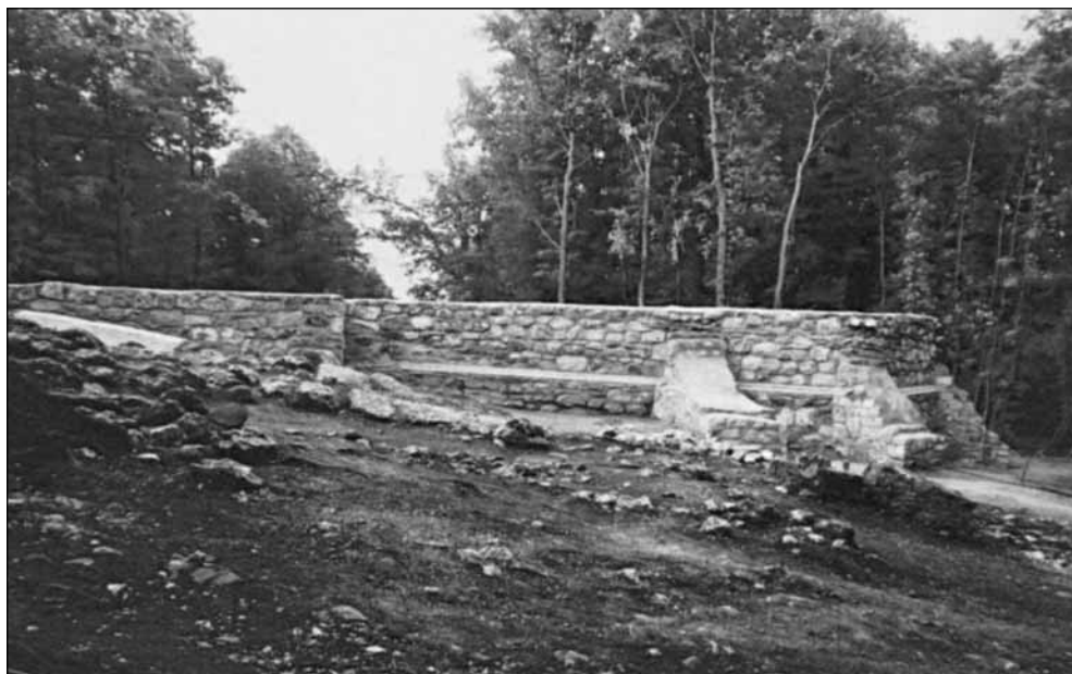
Pogled na južni zid svetišta nakon konzervacije
